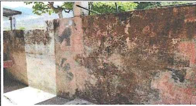
FOTO 1 PINTURA EN PAREDES DE LOS SANITARIOS.
