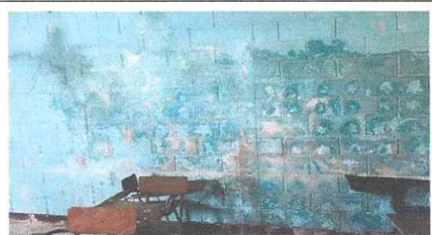
FOTO 2 PINTURA EN AULAS DE TODO EL ESTABLECIMIENTO
